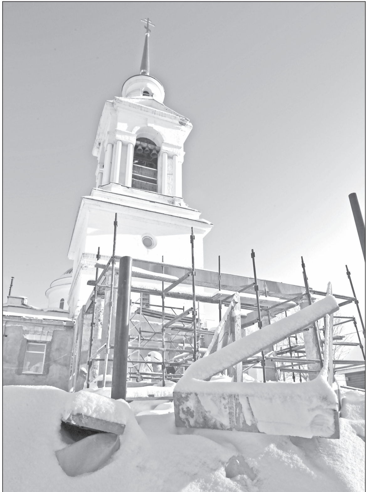
В храме обещают: после реконструкции крыльца с обязательным сохранением исторических колонн, внешний вид храма будет ничуть не хуже, при этом выход станет безопаснее для прихожан...
