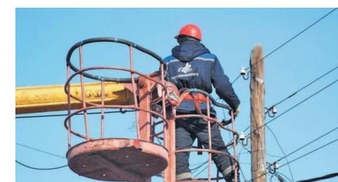
там двух новых фельдшерско-акушерских пунктов. Также проводится реконструкция воздушной линии 10 кВ Вьюхино, здесь планируется установить порядка 40 железобетонных опор, смонтировать 6,2 км провода. Реконструкция позволит повысить качество электроснабжения потребителей в поселке Мельзавод и на прилегающих территориях.
