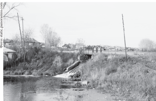
На реконструкцию ГТС Ачита потребуется 30 млн. рублей
