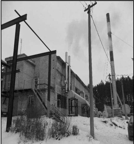
Фото 1.Кот №1. Общий вид здание котельной
