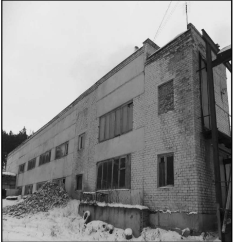
Фото 3.Кот №1. Вид здания котельной
