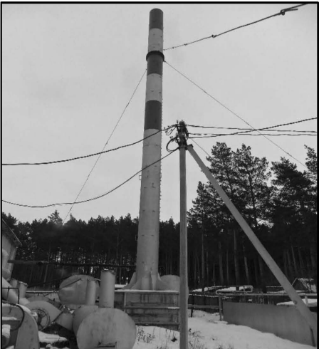
Фото 2.Кот №1. Дымовая труба
