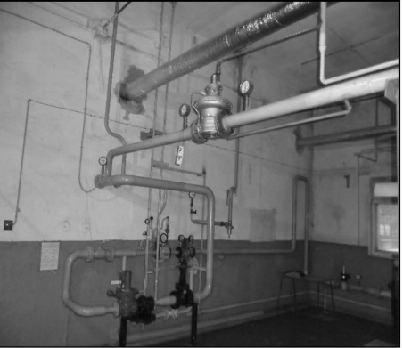
Фото 15. Кот №1. Узел регулирования и учета газа
