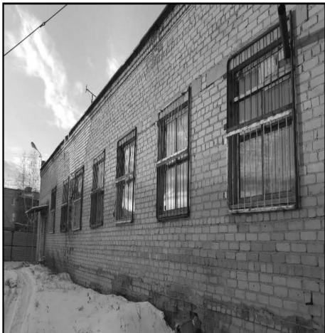
Фото 62. Кот. №7.Вид сбоку
