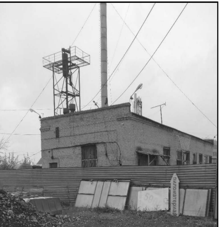
Фото 63. Кот. №7. Общий вид
