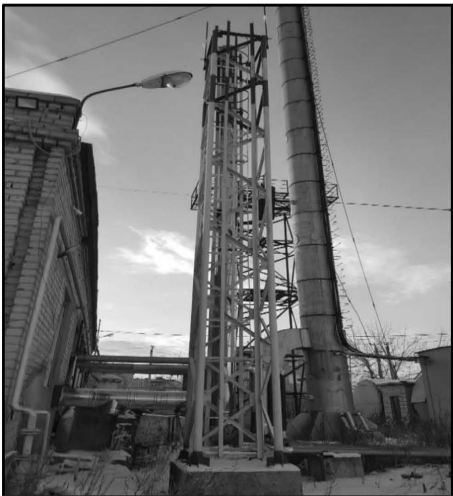
Фото 61. Кот. №7.Дымовая труба
