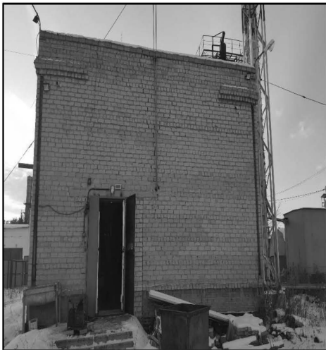
Фото 60. Кот. №7. Общий вид
