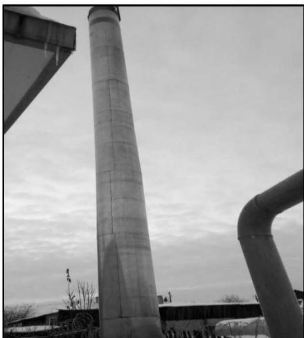
Фото 85. Кот.№11. Дымовая труба
