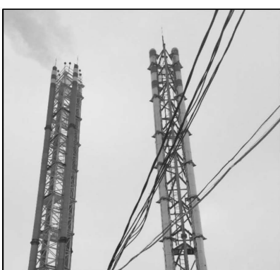
Фото 83. Кот. № 8. Дымовые трубы
