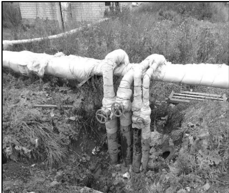
Фото 100-101 Теплосеть от котельной №1. Направление «п. Светлый 1-33», Ответвление на детский сад
