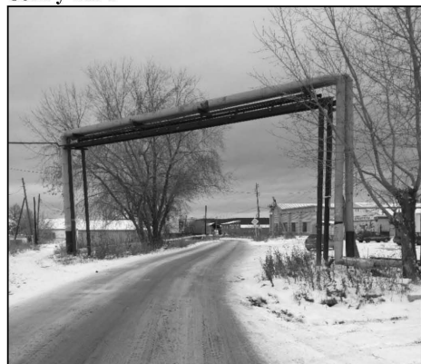
Фото 156-157 Кот. №5. Теплосети в направлении ТП-1 – ул. Октябрьская – ул. Энгельса Компенсатор через ул. Белинского
