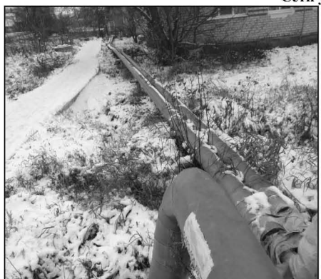
Фото 174-175 Кот. №5 Теплосетив направлении ТП-2 – ул. Курчатова Ответвление на д. ул. Курчатова 28а, ул. Горбачева 19 Врезка на д. Курчатова 28а
