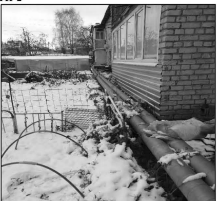
Фото 174-175 Кот. №5 Теплосетив направлении ТП-2 – ул. Курчатова Ответвление на д. ул. Курчатова 28а, ул. Горбачева 19 Врезка на д. Курчатова 28а
